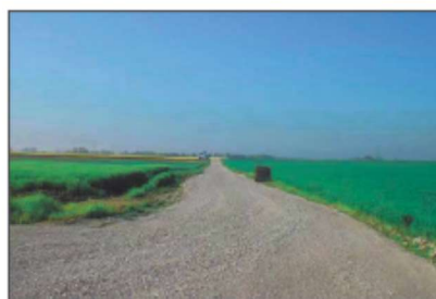
Photo 30 : Exemple de chemin d'accès après renforcement (Source : BE Jacquel et Chatillon)
